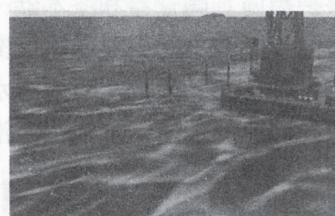
**压载** 沉井下沉到预定深度的任务需要通过静压完成，也就是把预制好的水泥沉块依次平稳放置到沉井上部，通过加大沉井重量促使其逐渐下沉。因为采用了静压的方式，沉井在下压过程不会产生震动而且下沉速度相对均匀，可以最大限度地保护已罩在沉井内的“南海 I 号”的安全
