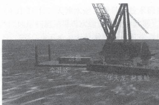
吊浮 通过亚洲地区起重能力最大的“华天龙”起重船和“全潜驳”配合作业。全潜驳拥有可以下沉到海底任意指定深度，然后再浮出海面的能力。用华天龙的巨臂将沉箱稳稳吊起，然后慢慢放到潜入水中的驳船上，再操纵驳船平稳上升到海面
